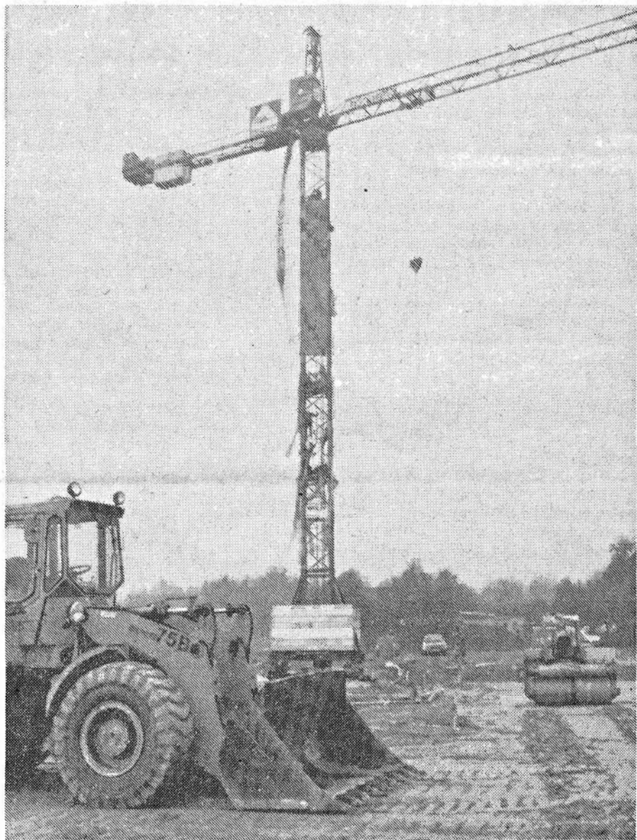
Seit gestern morgen halten Frauen vom Widerstandscamp in Reckershausen einen etwa 30 Meter hohen Baukran auf dem Nato-Baugelände besetzt.
